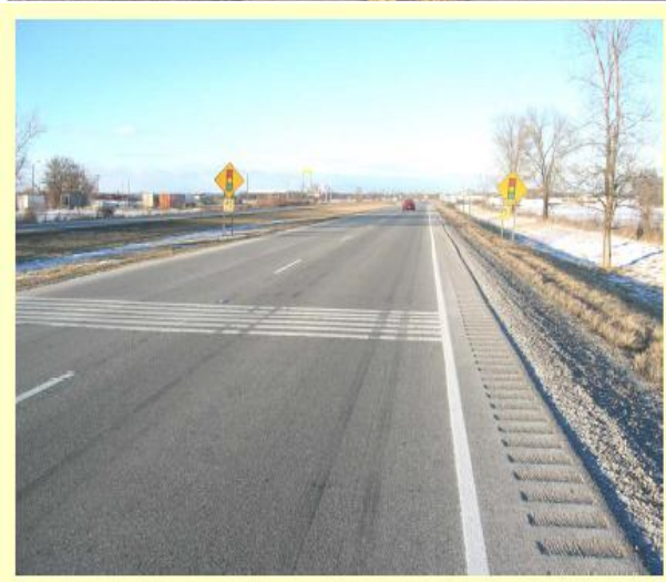
شکل ۴- نمونه های اجرا شده خط کشیهای ارتعاشی طولی و عرضی
