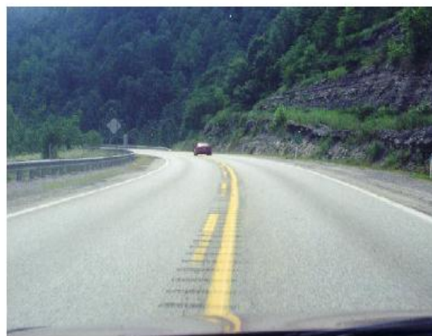
شکل ۴- نمونه های اجرا شده خط کشیهای ارتعاشی طولی و عرضی
