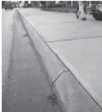
شکل ۶-۱۰- جدولهای بامقطع مدور که امکان تخلف رانندگان و ورود به عرض پیاده‌رو را فراهم می‌نمایند.
