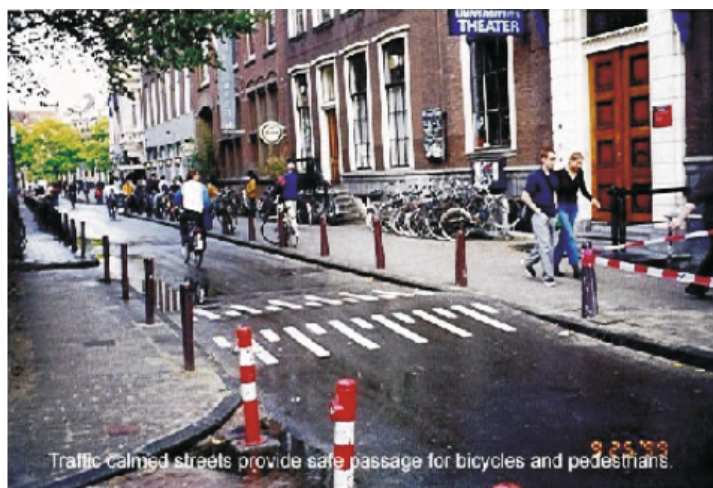
شکل (۲۷) - نمونه ای از تعریض سازی پیاده رو و کاهش عرض سواره رو
