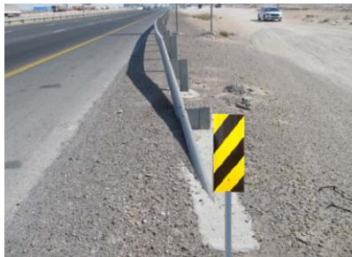
ب: بالای شکل کردن قسمت ابتدایی گاردریل
