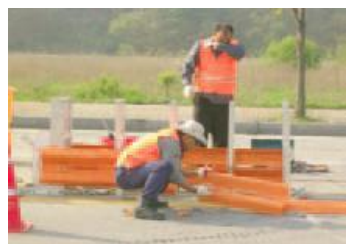
۶-۴۸- نصب دیواره‌ی ضربه‌گیر
