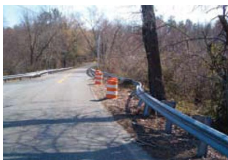
تصویر ۲۹: گذاشتن بشکه تا هنگام رفع خرابی نوع یک
