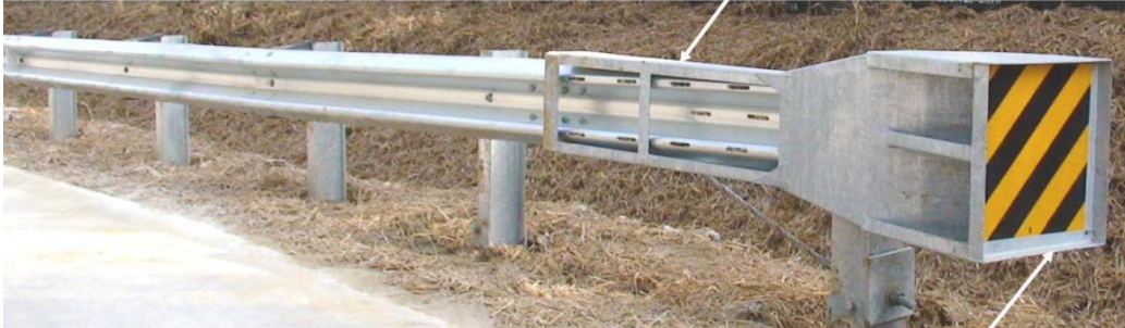
سر ضربه‌پذیر سرسپری (اشکار شده با شیرنگ)
