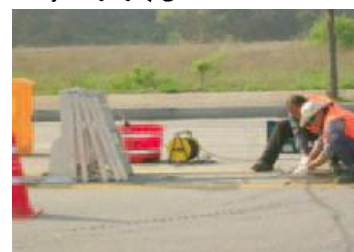
۵-۴۸- سوار کردن تسمه و چارچوب
