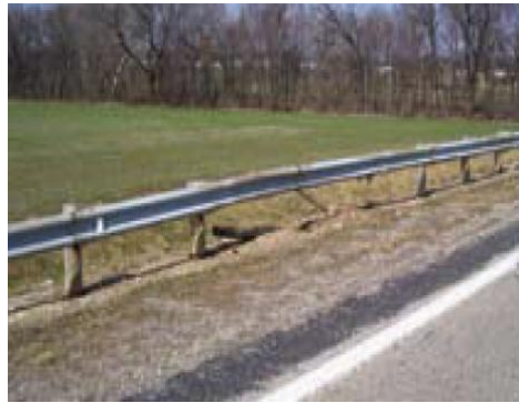
الف: یک یا ۲ پایه خراب شده و سپر سالم است ب: اجزای حفاظ سالم و عقب‌زدگی سپر کمتر از ۱۵ سانتیمتر تصویر ۳۰: انواع خرابی نوع ۲
