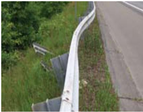
الف: یک یا ۲ پایه خراب شده و سپر سالم است ب: اجزای حفاظ سالم و عقب‌زدگی سپر کمتر از ۱۵ سانتیمتر تصویر ۳۰: انواع خرابی نوع ۲
