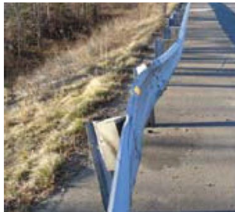
تصویر ۳۱: خرابی نوع ۳ (همه اجزا به جز سپر سالم هستند. عقب‌زدگی سپر کمتر از ۱۵ سانتیمتر و ناهم‌ترازی ارتفاع آن کمتر از ۸ سانتیمتر است.)
