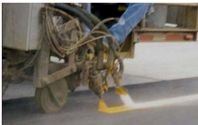
تصویر (۱۴): نحوه پاشش دانه شیشه‌ای بر سطح رنگ
