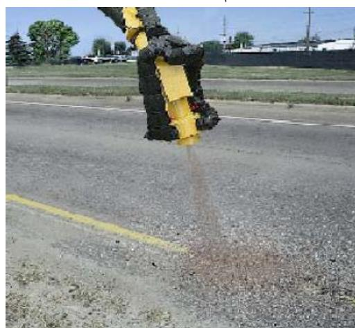
شکل ۵-۳- کاربرد پوششی از سنگدانه خشک
