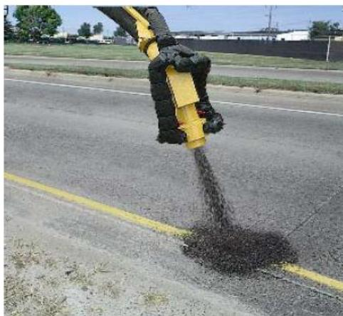
شکل ۳-۴- تزریق با فشار مخلوط قیر و سنگدانه
