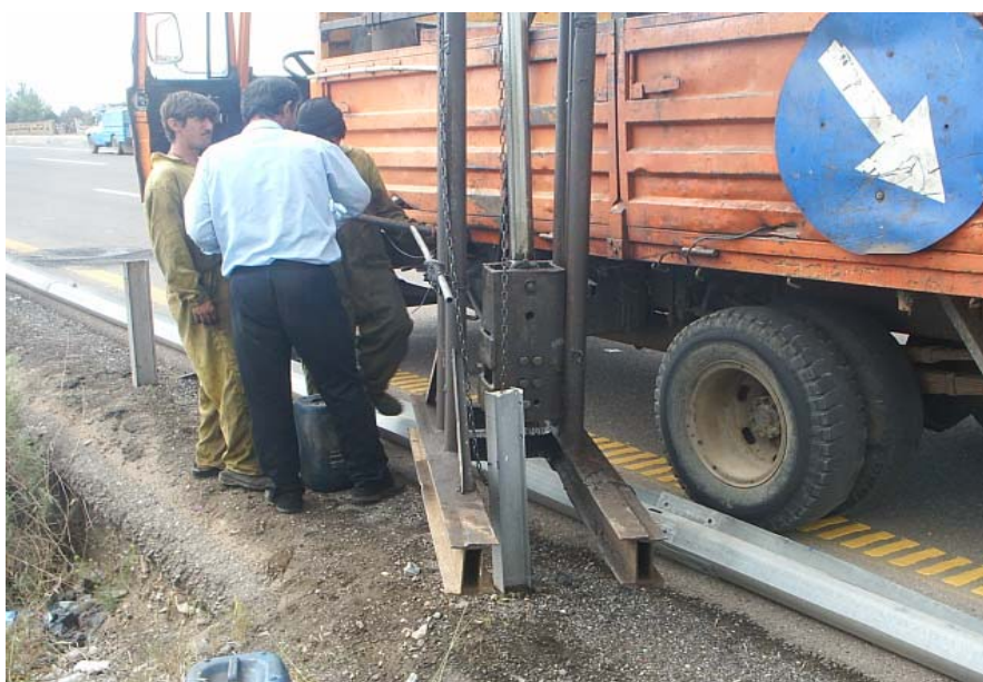
شکل ۴-۱- عملیات تعویض حفاظ فولادی
