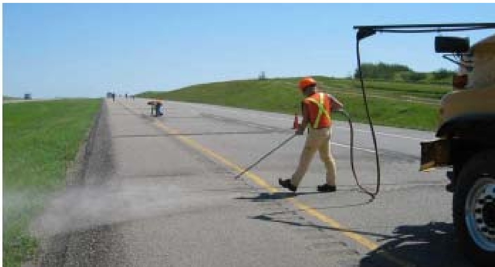
شکل ۳-۱- نظافت محل قبل از خط‌کشی
