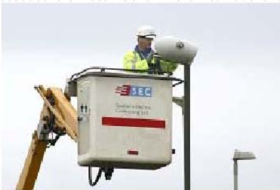
شکل ۴-۴- عملیات تعویض لامپ و نظافت چراغ سیستم روشنایی
