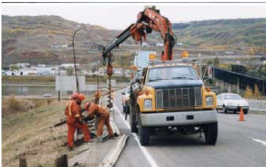
شکل ۴-۱- عملیات تعویض حفاظ فولادی
