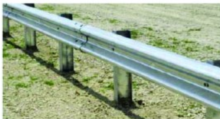
شکل (۶). نمونه‌ای از گارد ریل دو موجی
